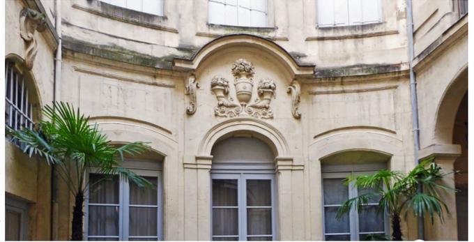
Explication des fenêtres qui auraient été « bouchées » : pour l'harmonie des façades, on a créé des fenêtres en trompe l'œil , puis avec l'apparition des salles de bains, il est apparu nécessaire de percer des fenêtres . Les fenêtres ne sont pas bouchées mais au contraire percées !
